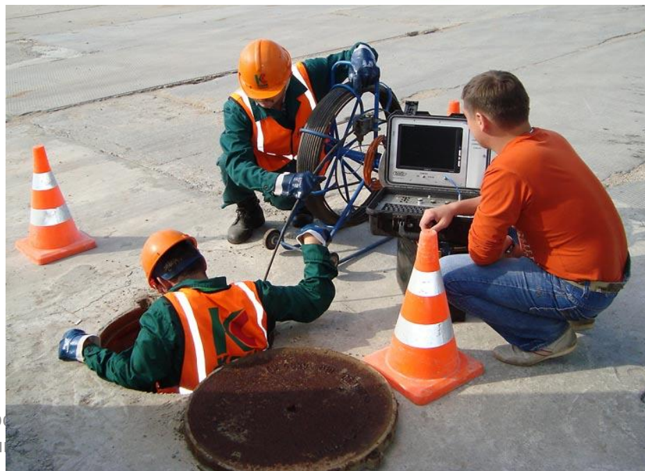
Робототехнический комплекс FWL 100 Самоходный телеинспекционный
